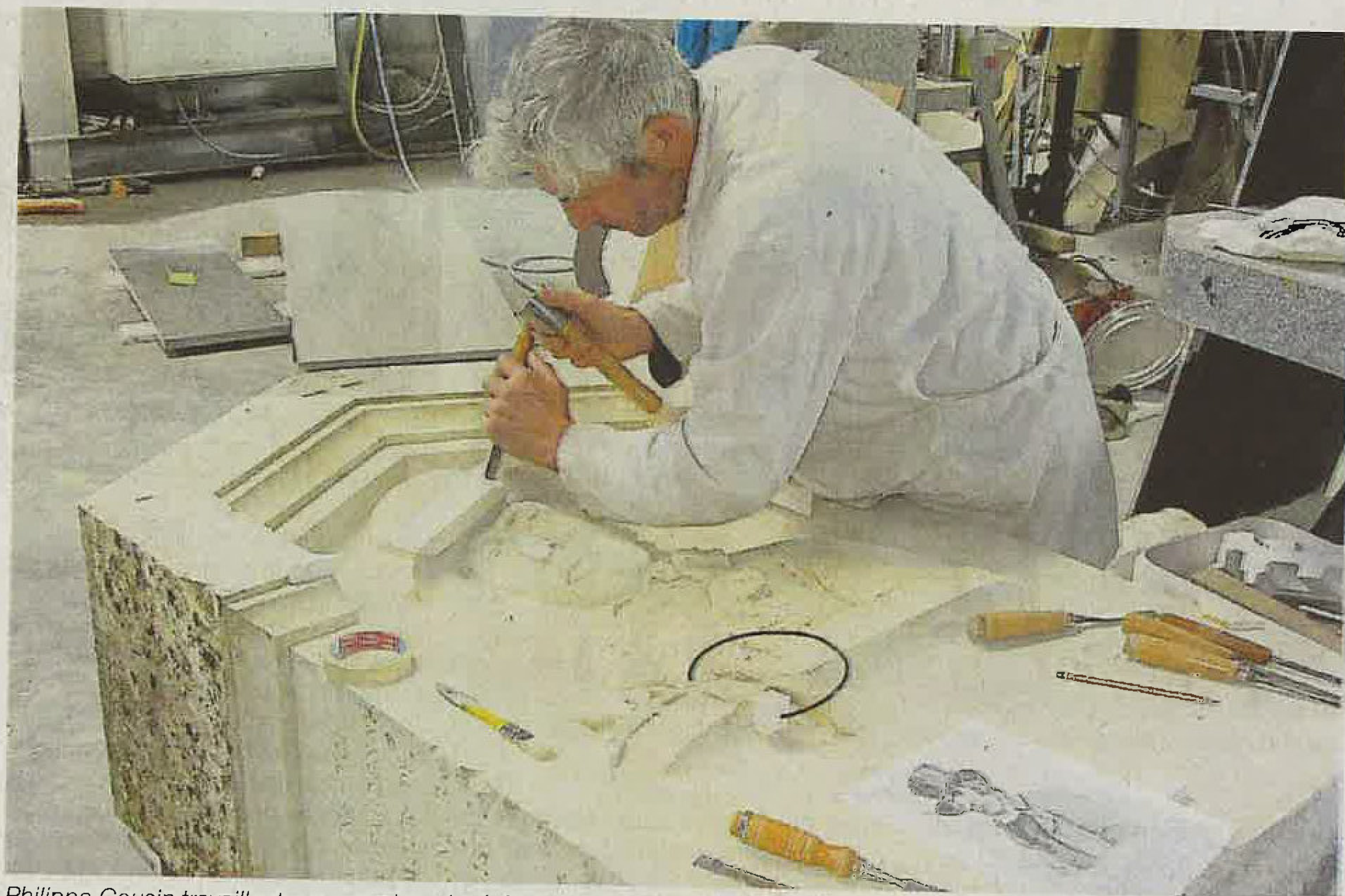
Philippe Cousin travaillant sur une pierre insérée dans une zone très dégradée.
